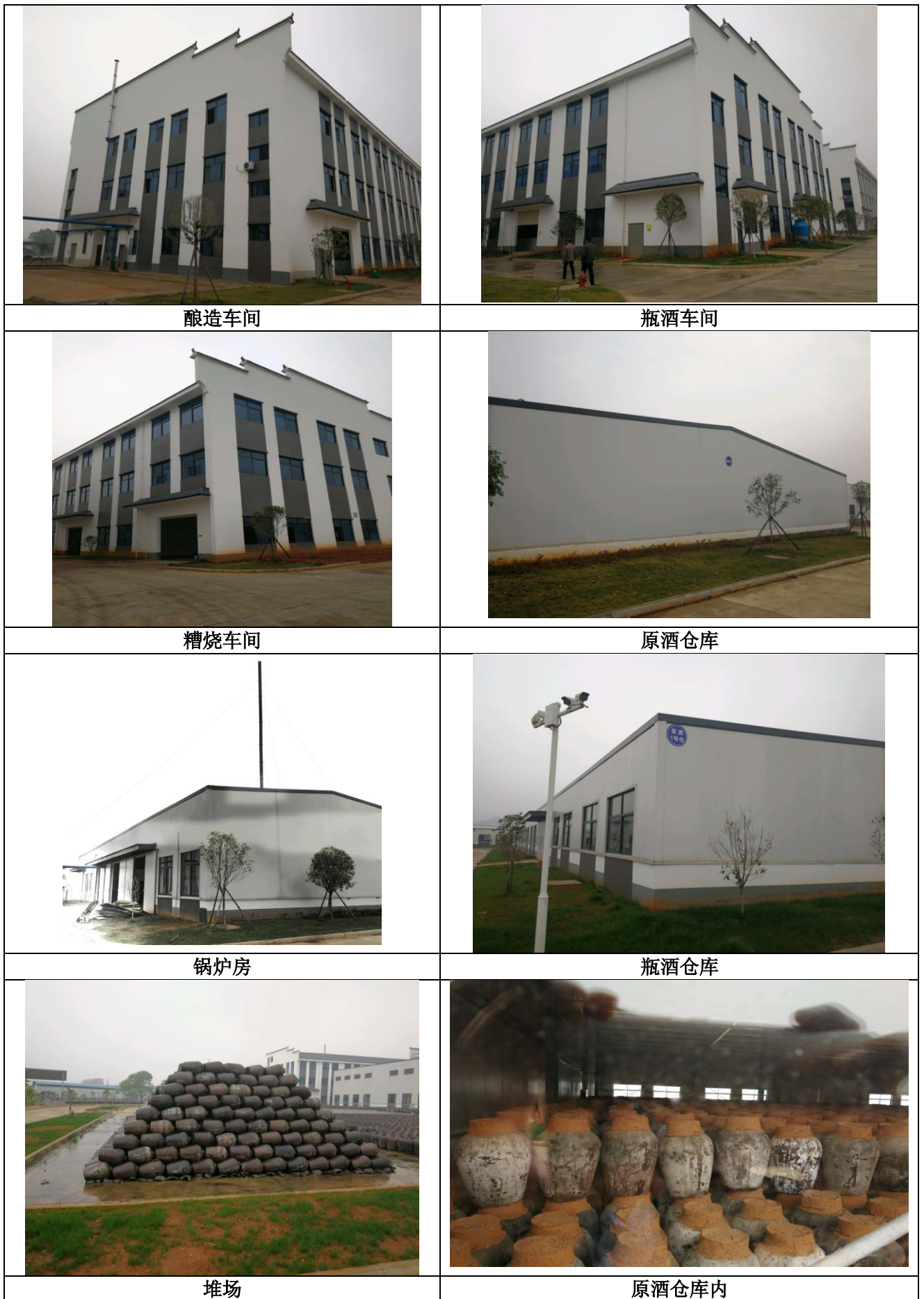
图3-5 项目主要车间构筑物照片
